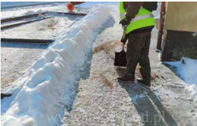
Ul. 3 Maja - oczyszczanie schodów z lodu i śniegu
