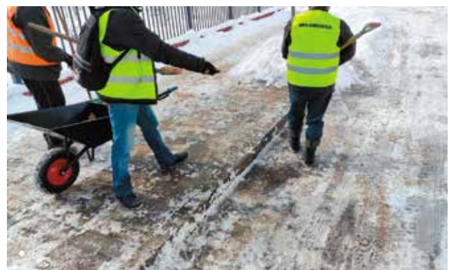
Ul. Żeromskiego - udrożnianie przejść dla pieszych
